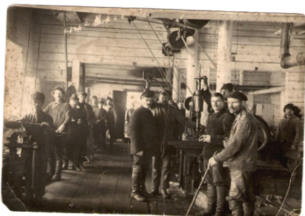
Слесарно-токарные мастерские 1923г. СРЗ пам. Двержиского. г. Пермь
